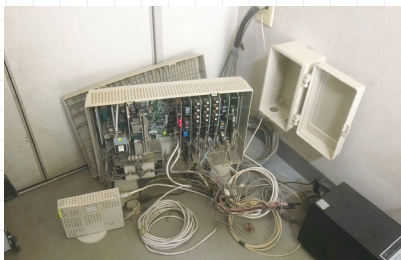
▲15年以上使用した従来型PBX。同じ構成のまま単純に更新すると高額になります
