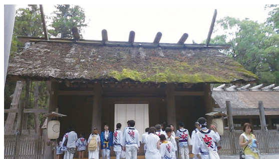
▲ 20年経過すると社殿はずいぶん傷んでしまいます
