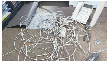
▲スパゲッティ状態になった電話配線を全て撤去！
