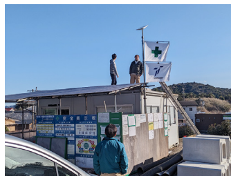
現場事務所のポール上部に アンテナを設置しました
