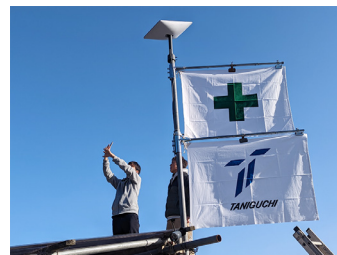
衛星の向きに合わせて アンテナを調節して設置完了！
